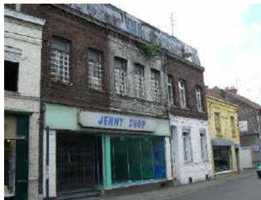
façades de la rue Jean Jaurès
